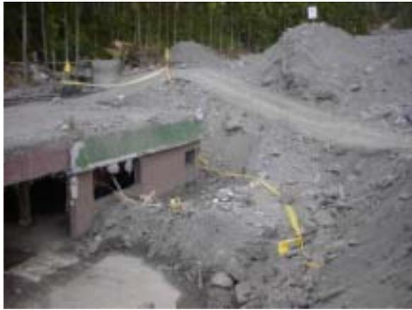
写真 1 花蓮県光復郷大興村で発生した土石流によって埋没した白雲山荘の発掘状況
