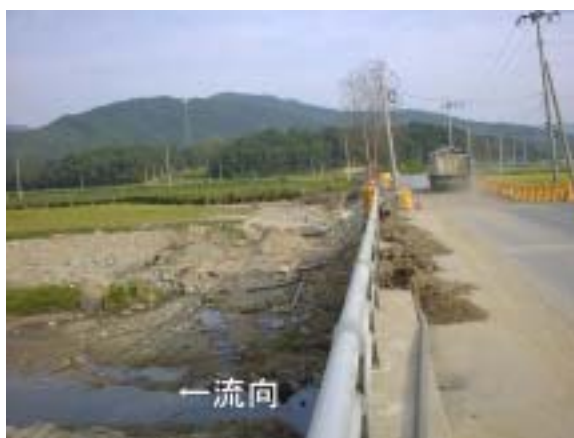
写真7 中央のブドウ畑の奥が2～3mの段丘崖で，そこまで洪水痕跡がある．橋の下流(左)側に堤高3～4mの堤防があったが完全に流失したとのこと．
