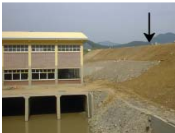
写真5 矢印付近が堤防決壊部．左がポンプ場．この堤防の反対側が黄江遊水部．手前が氾濫域．
