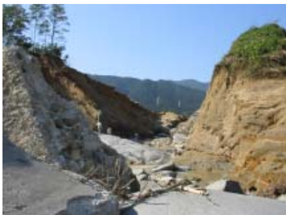
写真1 決壊した余水吐を下流側から見る．取り付け部から完全に流失している．
