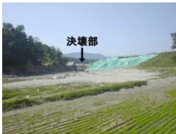
写真1 決壊した余水吐を下流側から見る．取り付け部から完全に流失している．
