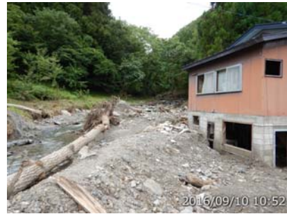
写真2 岩手県岩泉町二升石。「土砂」と判断のケース。ただし土砂流出は見られるが家屋は流失・倒壊していない。
